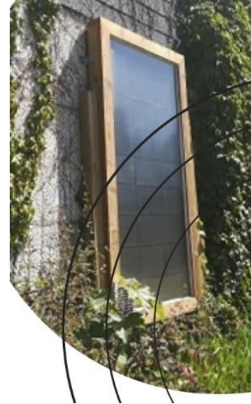
collecteur solaire dans tiny house Enerlog, 2021
